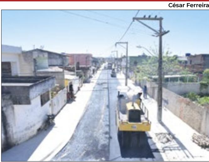
Trabalhos incluem pavimentação e coleta de esgoto
