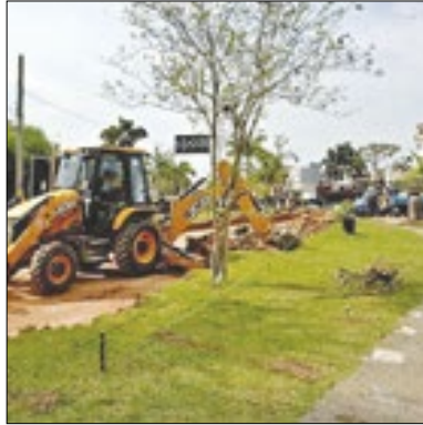
Obras do viaduto em Niterói
