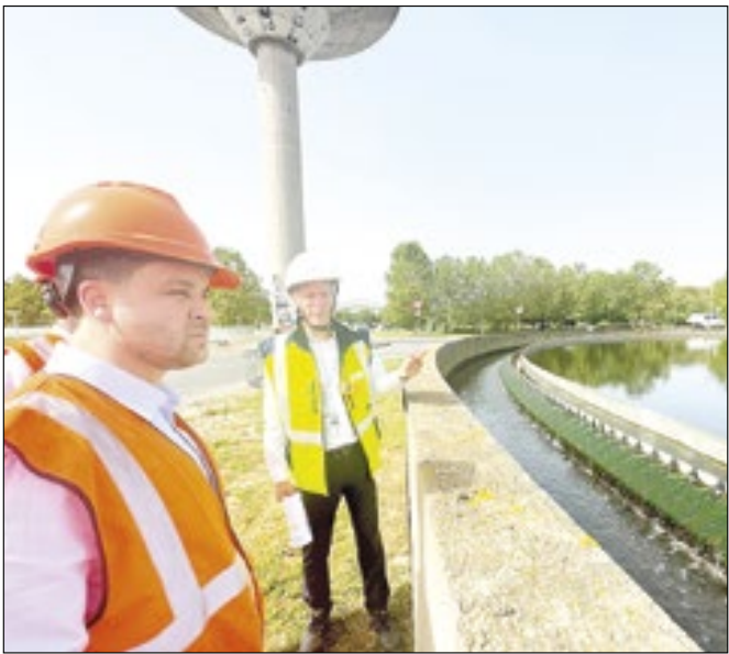
O vice-governador e secretário de Ambiente do Rio, Thiago Pampolha, está em Paris, na França, e realizou uma visita de campo às obras de despoluição do Rio Sena, com técnicos da SIAAP
