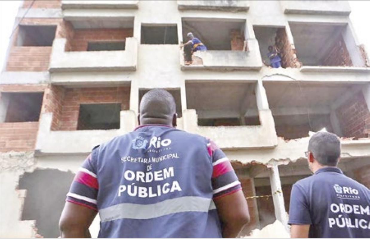
Prédio de seis andares foi demolido na Muzema, durante a ação conjunta
